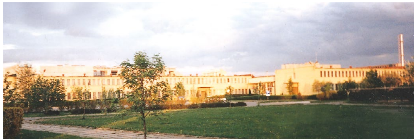
Budynki typu „Zębiec” – 1986 r.
