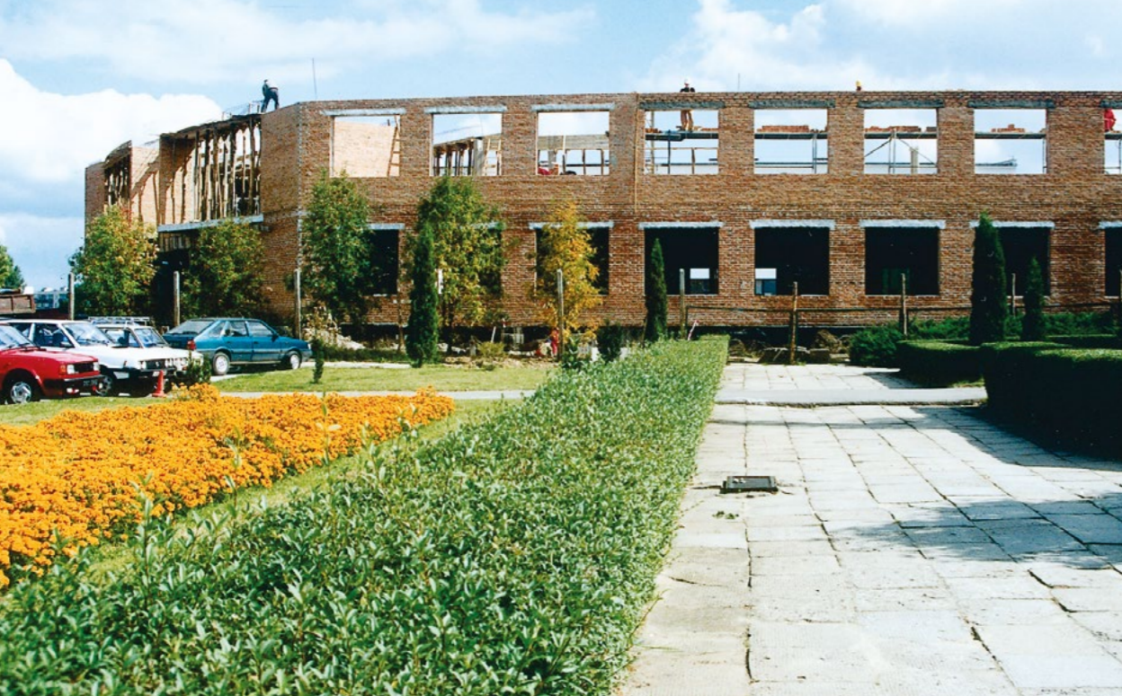
Budynek C – Organizacji Badań Naukowych (widok zewnętrzny) w trakcie prac budowlanych – 1998 r.
